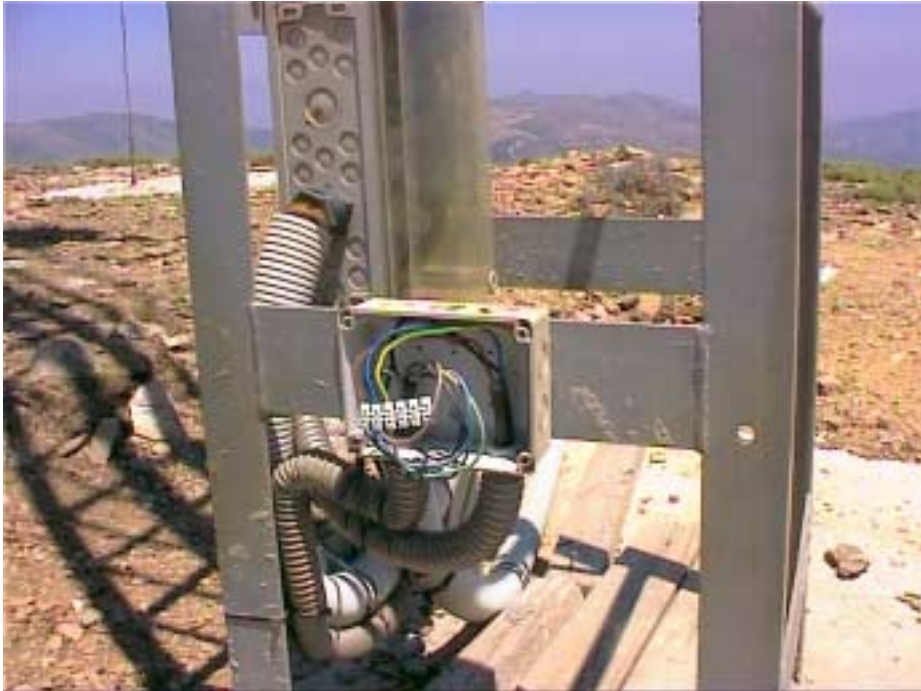
Bild 12: Klemmkasten an Windenergie-Anlage
