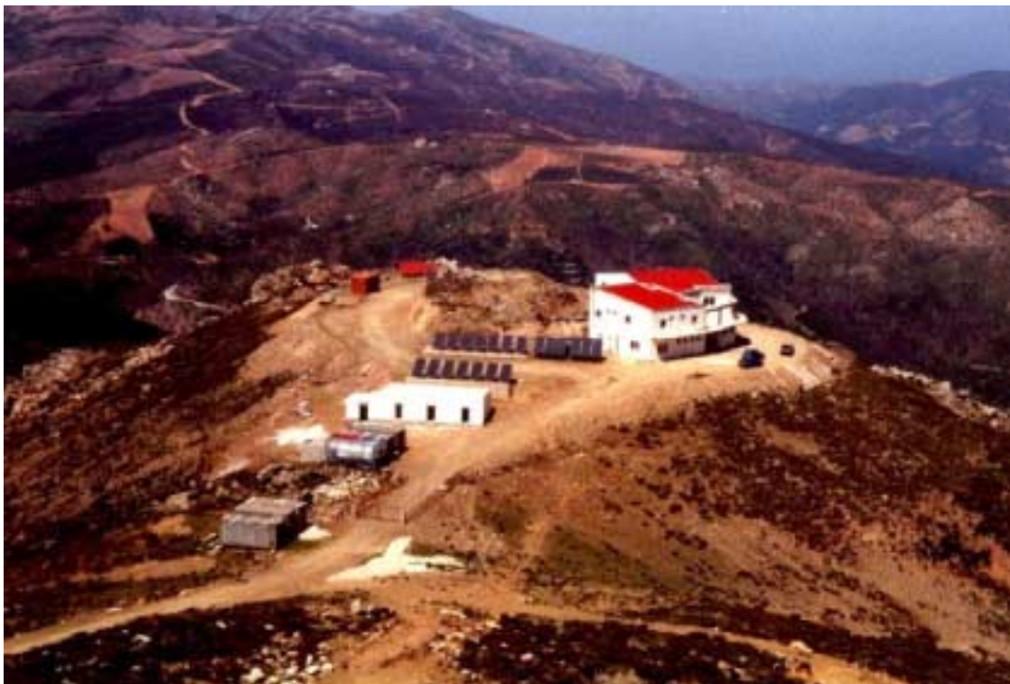
Bild 1: Gesamtübersicht der Anlage VATALI
