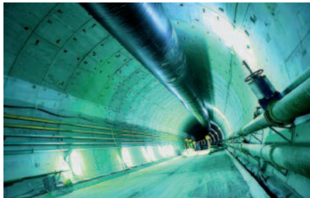
Mit Quellgummis abgedichtete Betonsegmente (Tübbing) des Eisenbahntunnels Zürich-Thalwil
