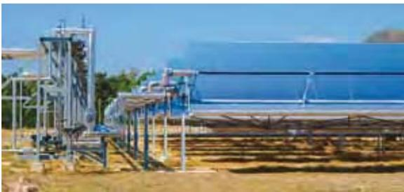
Parabolspiegel bündeln das Sonnenlicht. Die dabei gewonnene Energie wird in Wärme umgewandelt.
