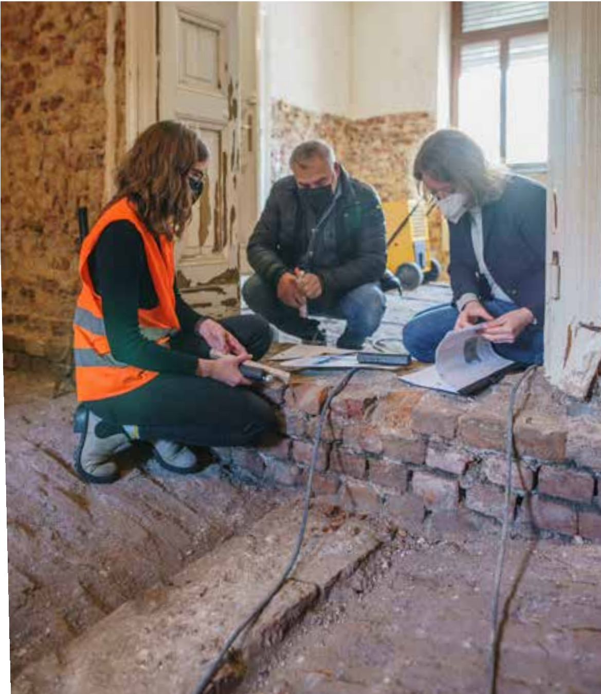
Sylvia Carola Schuster (rechts) und Tina Fandel besprechen mit dem Hauseigentümer, wie die Flutschäden beseitigt werden können
