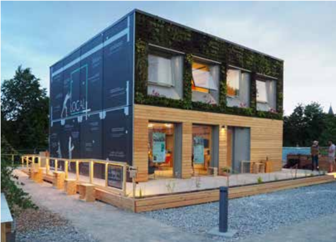
Der Lohn für mehr als zwei Jahre Arbeit: das fertige Haus des LOCAL+-Teams auf dem Wettbewerbsgelände in Wuppertal
