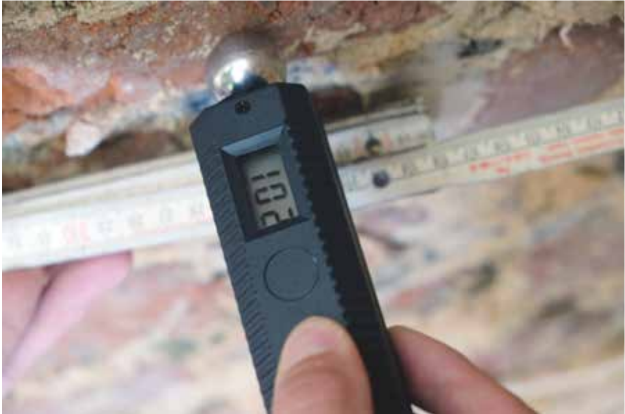
Zur Arbeit der Studierenden gehört auch die Messung der Feuchtigkeit in den Wänden
