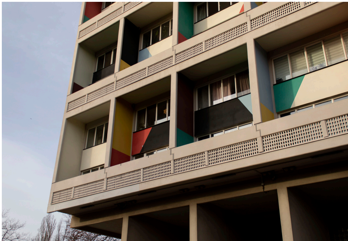
[11] Frontalansicht des Unité d'Habitation
