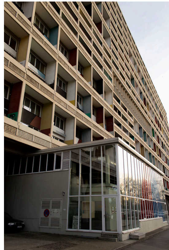
[12] Technikraum des Unité d'Habitation
