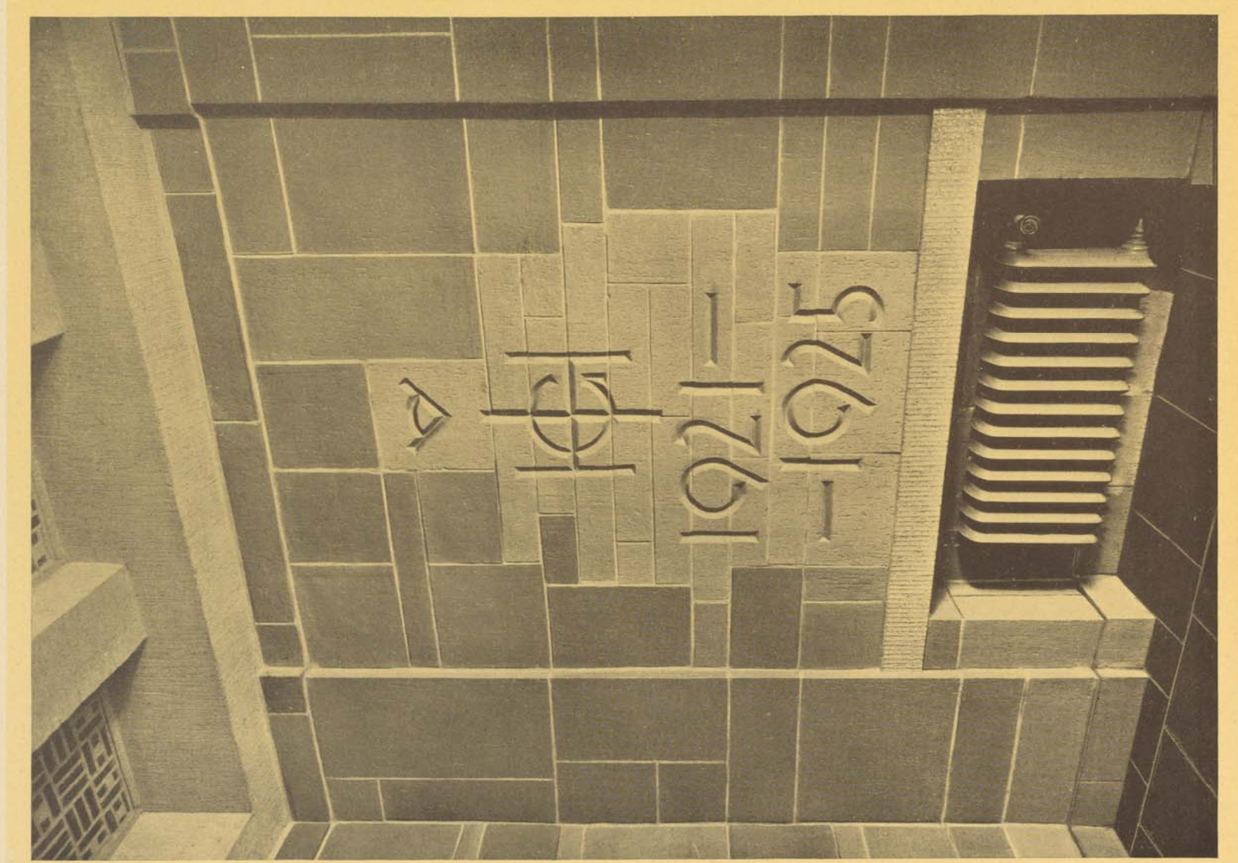
Kleiner Eingangraum Gute-Hoffnungs-Hütte Oberhausen, Rheinland (Wände: helle und dunkle grüne Mattglasur; Decke: helle gelblich-rötliche Lederfarbe) Entwurf: Professor Peter Behrens, Berlin-Neubabelsberg
