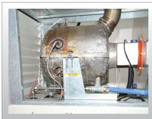
Mikroturbine Capstone C30 mit der Schwachgaszuführung (rechts)
