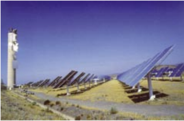
Solarthermisches Kraftwerk in Spanien
