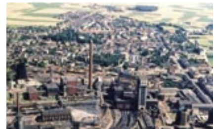
Das Alsdorfer Zechengelände zu Betriebszeiten
