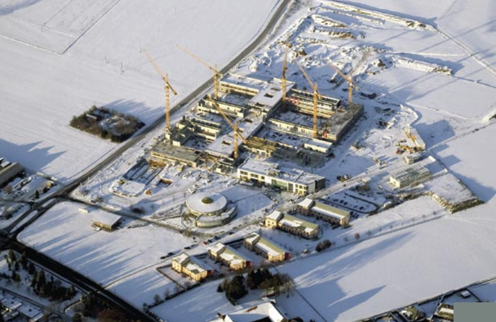
Blick auf die Entstehung des neuen Campus Jülich
