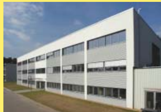
. . . und nach der Sanierung von Süden
