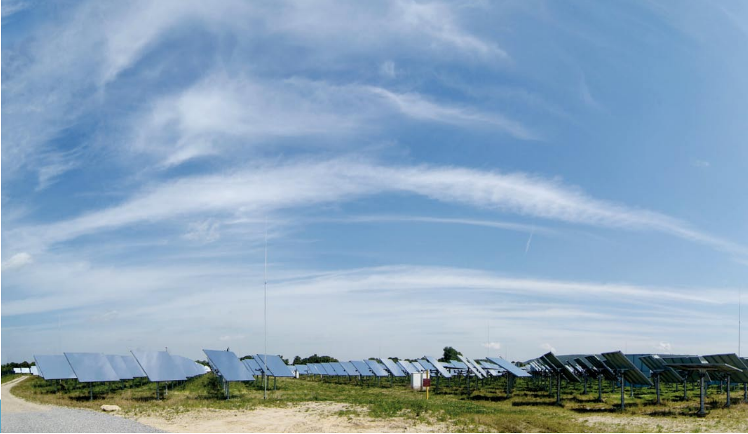
Mehr als 2000 Heliostaten lenken die Sonnenstrahlen um
