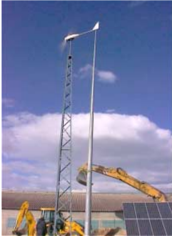
Bild 6: Aufstellung des Mastes
