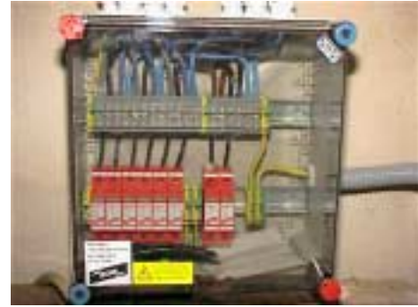
Bild 7: Anschaltkasten mit C-Ableitern
