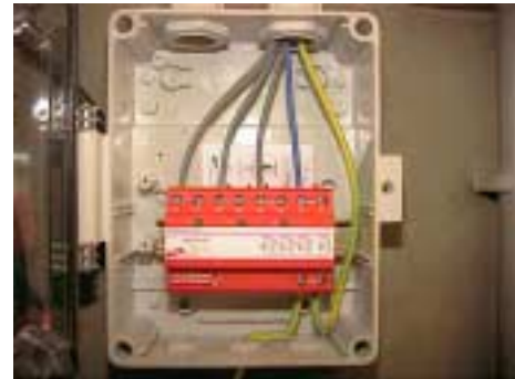
Bild 7: Anschaltkasten mit C-Ableitern
