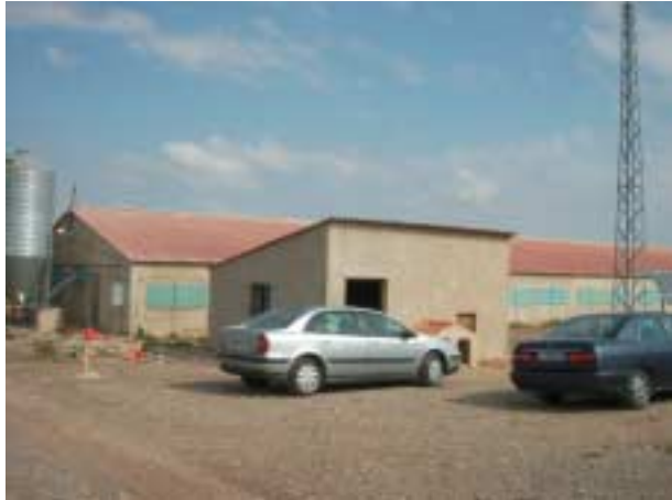
Bild 1: Elektrohaus mit dahinterliegendem Mastgebäude
