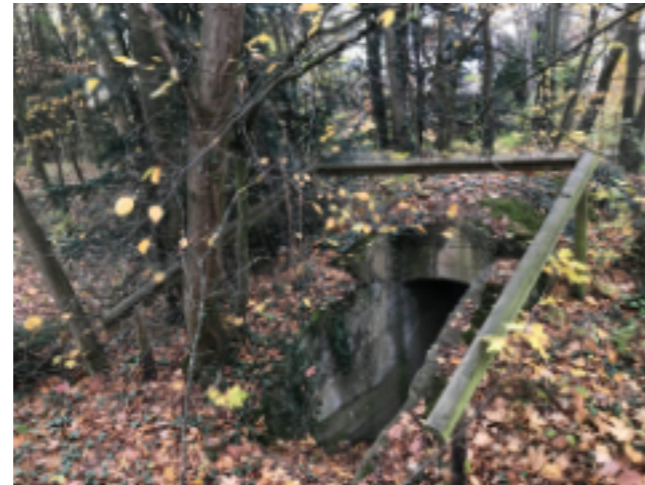
Außen Ansicht Bunker in Rheinbach
