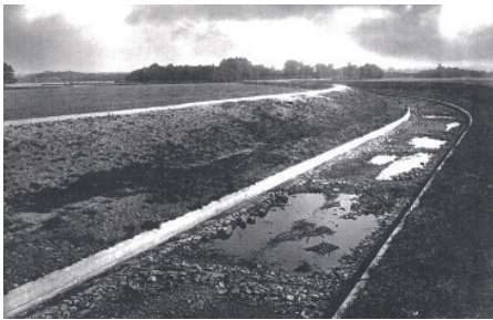
Abb. 1: Dhünnausbau (Quelle: Stadtarchiv Leverkusen)
